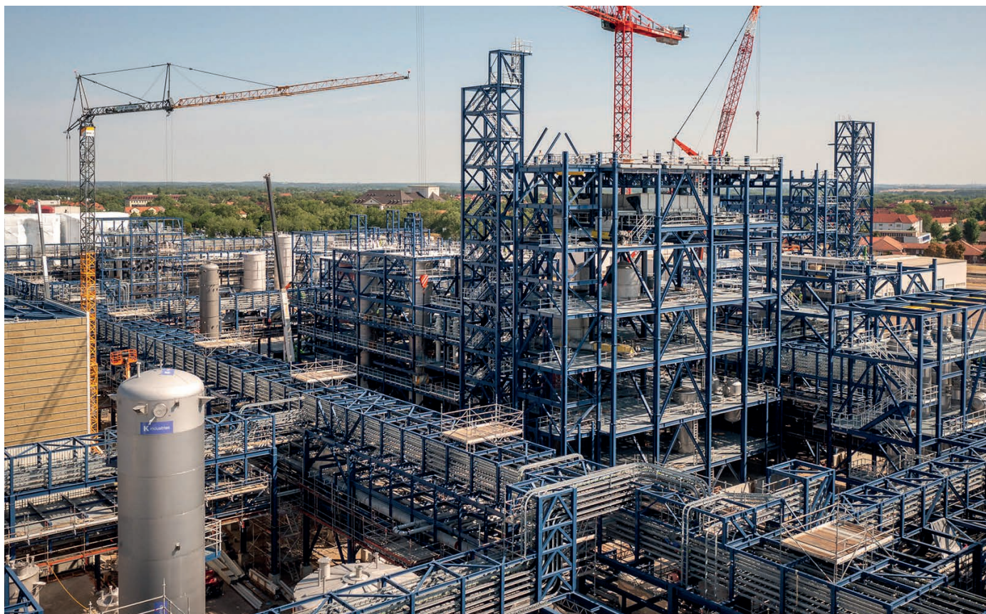
Construcción de biorrefinería industrial en Alemania.
