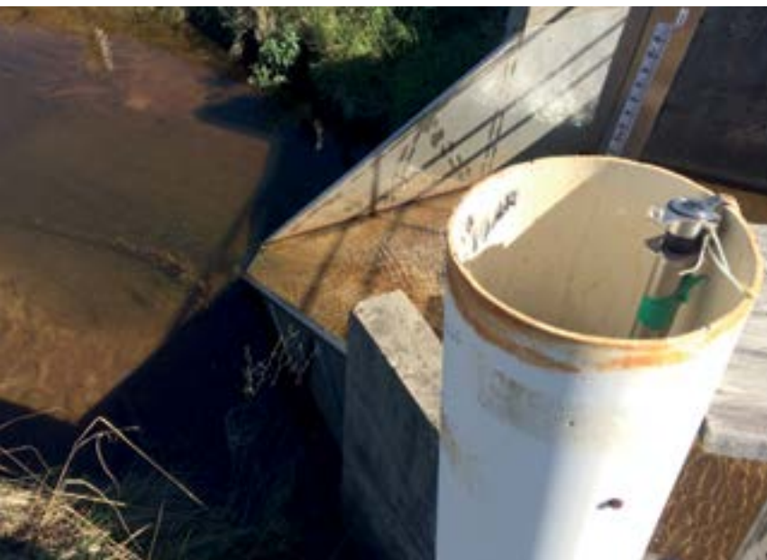
Estructura de medición de caudal en la microcuenca experimental El Viraró en Tacuarembó.
